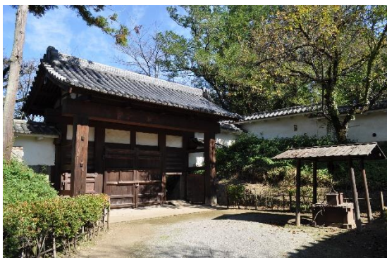
土橋門内部と復元井戸
