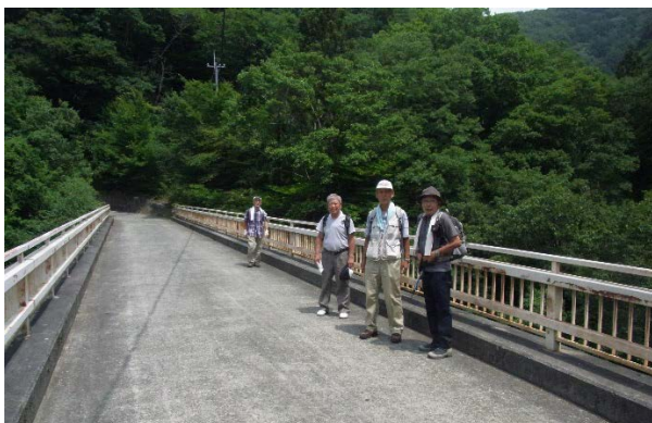
竜門峡入口竜門橋
