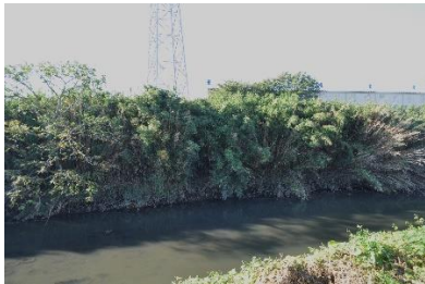
〔北から見た旧青柳橋跡〕
