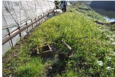
〔旧青柳橋橋脚〕
