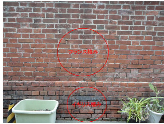
レンガ壁 土台がイギリス積み・上部がフランス積み 田代さんが見つけてくれました。(田代)
