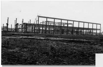
昭和41年3月 着々と工事は進み
