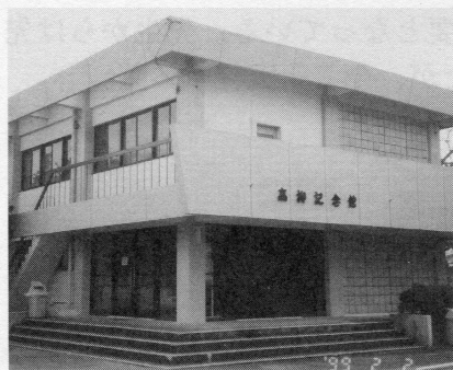
工学部内の高柳記念館。昭36年(1961)竣工
