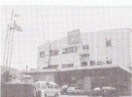
大倉山工場(横浜)/多層基板
