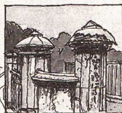
新東京八ツ見橋
